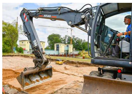
In Sichtweite zum Wehr Neuwerben entsteht gegenüber dem alten das neue Betriebsgebäude des LHW. Mitarbeiter der Havelberger Firma HTI haben hier gerade die Frostschutzschicht aufgebracht. FOTO: ANDREA SCHRÖDER
